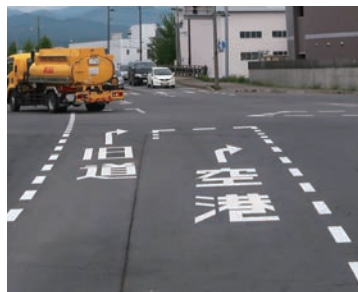
路面標示引き直し
