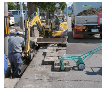
堆積した汚泥を重機も使って排出
