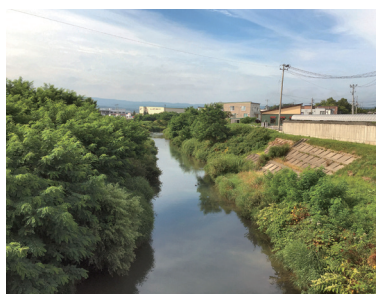
河川敷伐採前
