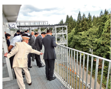
非常時使用する避難デッキ
