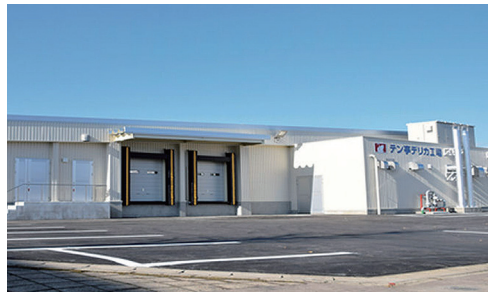
竣工したマエダ テン亭デリカ工場
