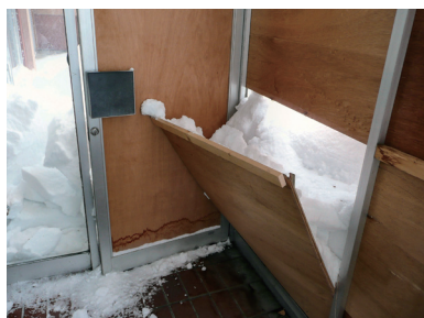
屋根からの落雪による被害
