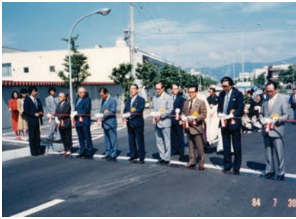
問屋橋の供用開始(昭和59年度)
