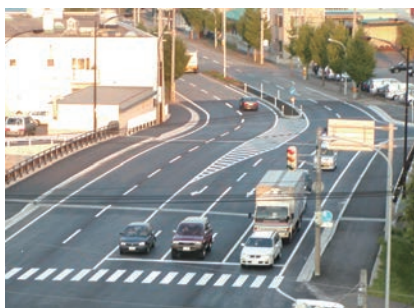
問屋橋上下2車線化工事が完了(平成14年度)
