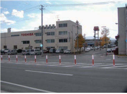
問屋橋東側T字路に右折防止用ポールを設置(平成18年度)
