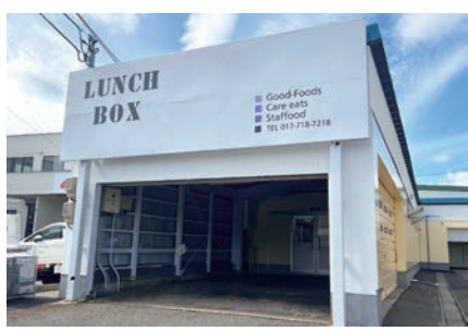
改修されたグッドフーズ施設
