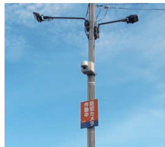
交換された防犯カメラ
