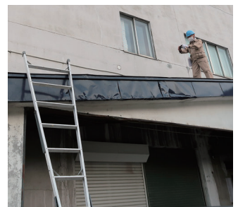
専門家が施設劣化状況現地調査
