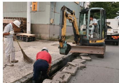
重機も使って泥上げ実施
