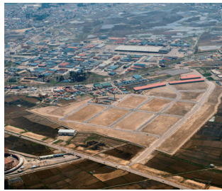
第二問屋町造成完成時
