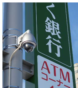
会館前に設置された防犯カメラ
